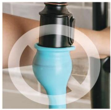
**5** Couvrez l'extrémité inférieure de l'élément (avec un doigt ou un bouchon bleu) et laissez l'eau remplir l'élément pendant environ 30 secondes, puis coupez l'eau.
